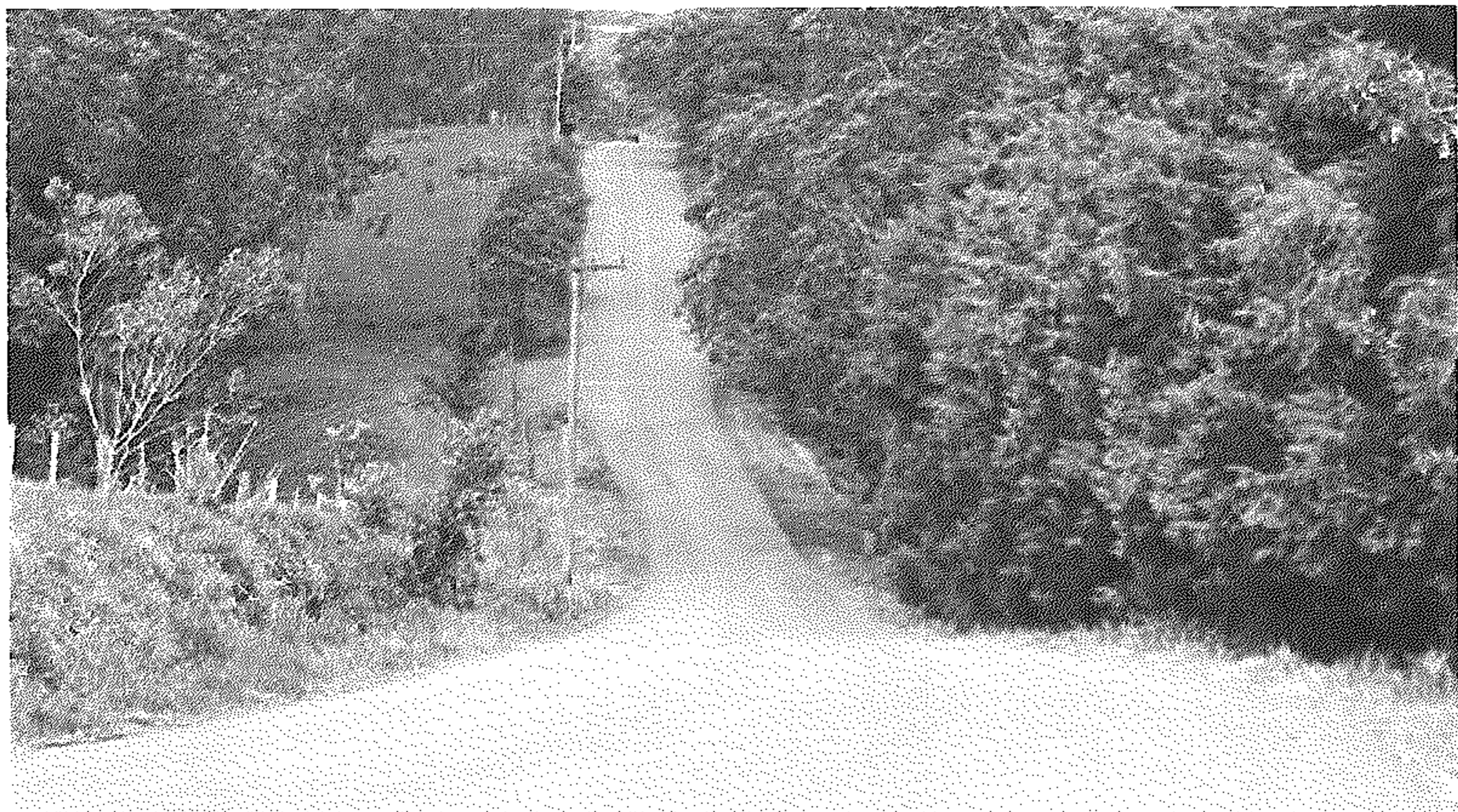
FOTO 02 – VISTA PASSAGEM EXECUTADA DA ESTRADA JOÃO DORIGAN
