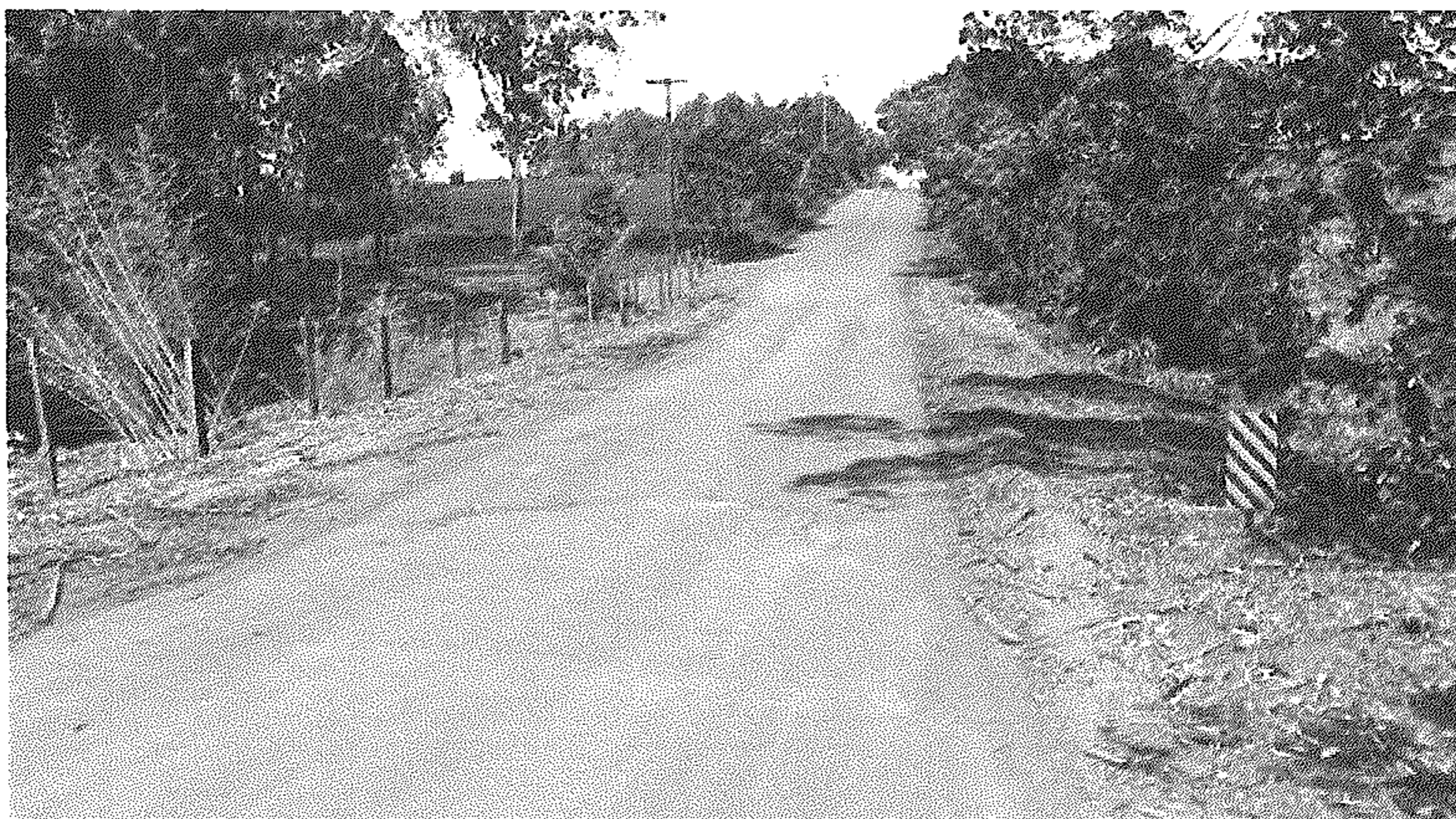
FOTO 03 – VISTA APROXIMADA DA PASSAGEM EXECUTADA DA ESTRADA JOÃO DORIGAN
