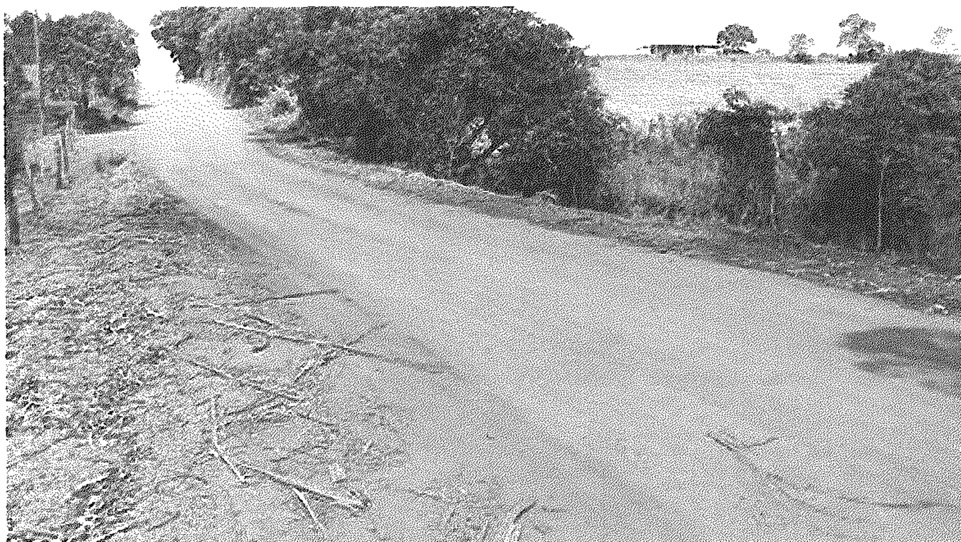
FOTO 04 – VISTA APROXIMADA DA PASSAGEM EXECUTADA DA ESTRADA JOÃO DORIGAN
