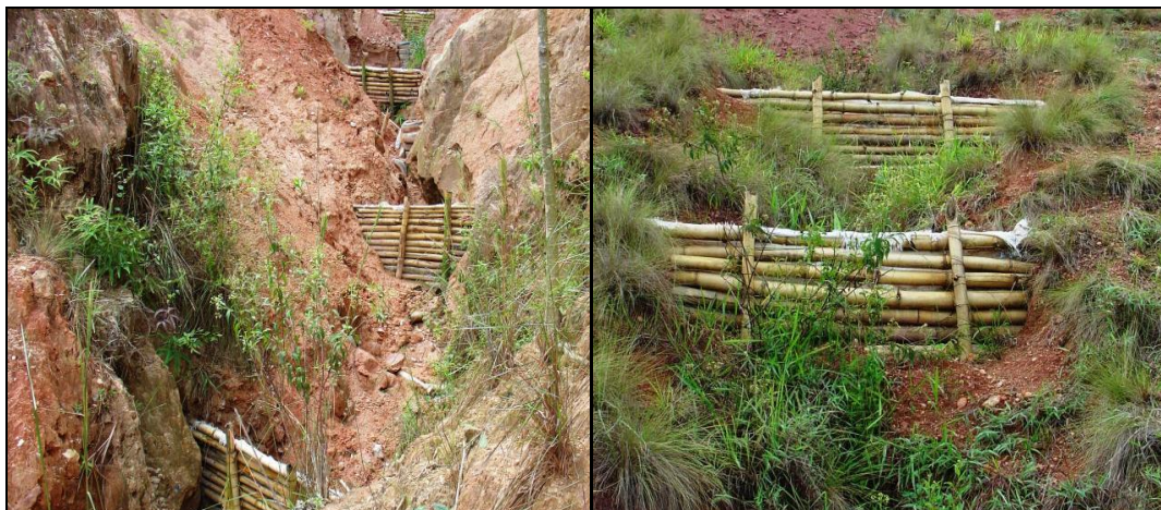
Figura 134 - Exemplo de aplicação de paliçadas.
