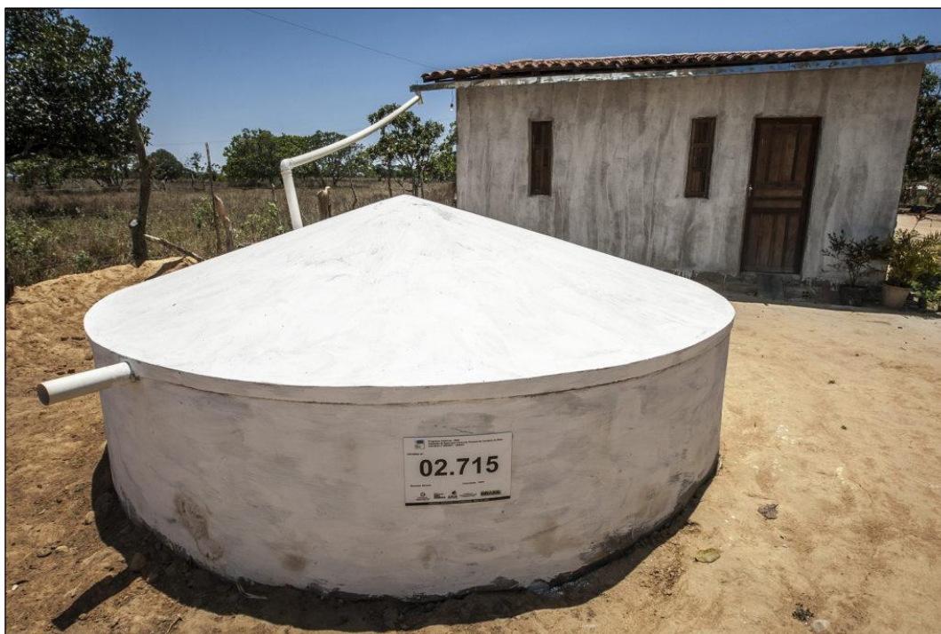
Figura 111 - Cisterna de superfície para armazenamento de águas pluviais.
