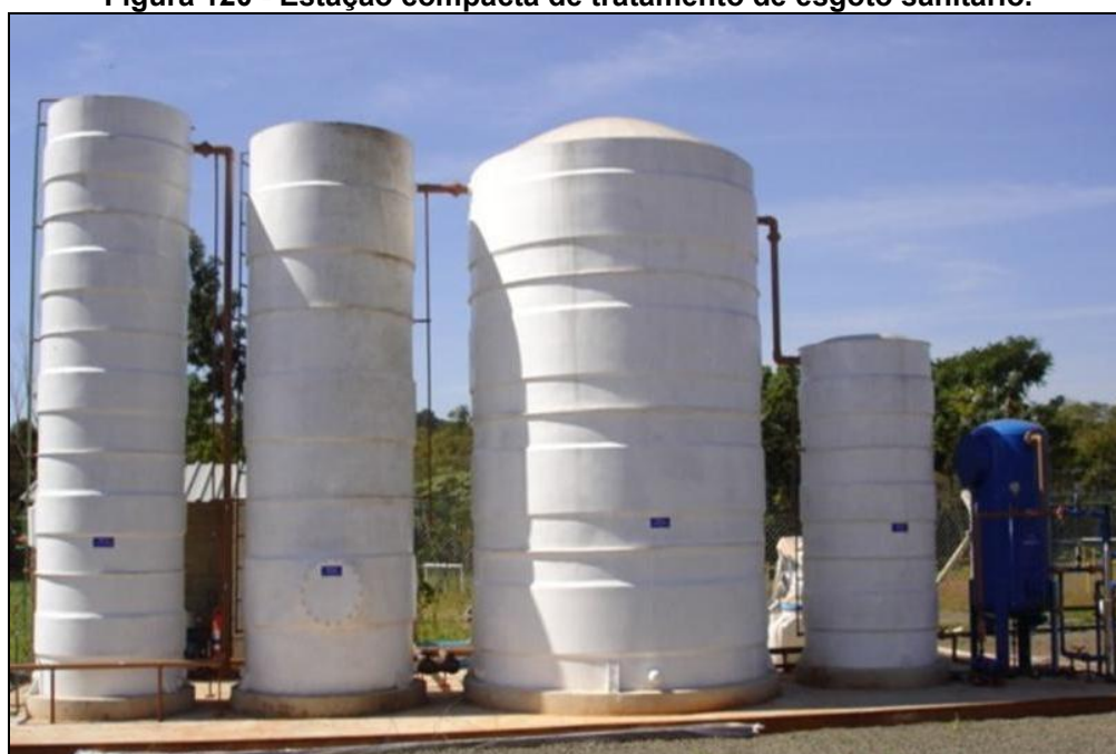
Figura 120 - Estação compacta de tratamento de esgoto sanitário.
