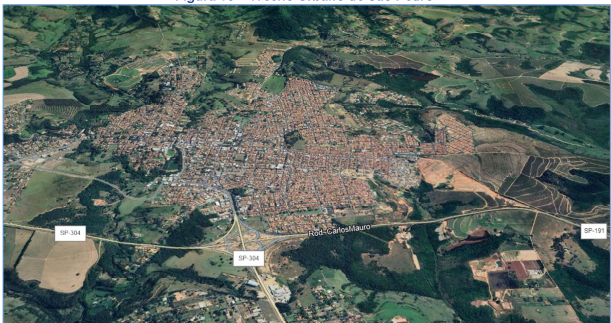
Figura 13 – Trecho Urbano de São Pedro
