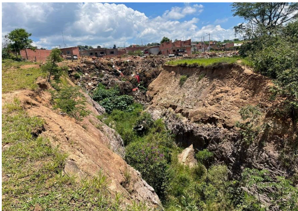
Figura 7: Exemplo de Voçoroca que acontece no município
